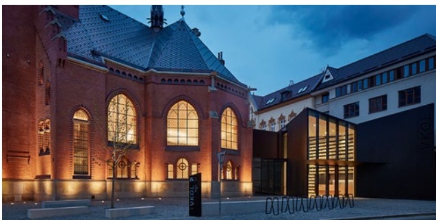
Vědecká knihovna Olomouc – stavební úpravy objektu Červeného kostela
