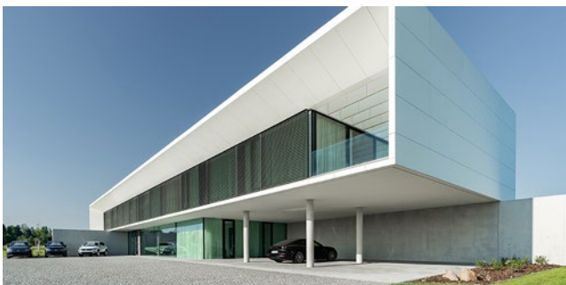
Administrativní budova Importo Klatovy Ing. Václav Pícka (ČKAIT 0202092, TP00)
