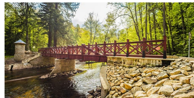
Rekonstrukce Červeného mostu v Babiččině údolí
