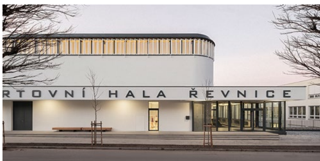
Sportovní hala Řevnice
