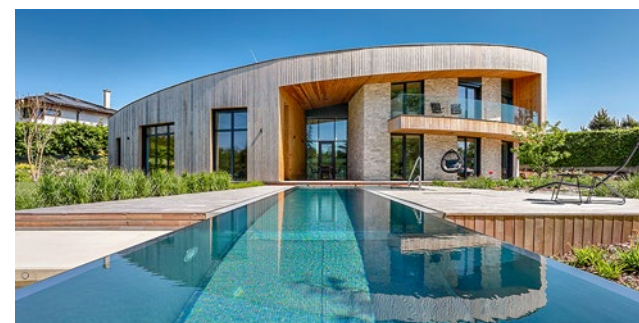
Čtvrtkruhový dům v Ostravě-Porubě
