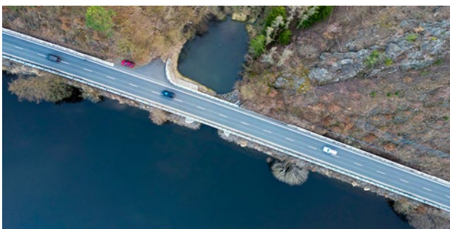
Rekonstrukce silnice II/102 v úseku Davle – Štěchovice Ing. David Dvořáček (ČKAIT 0013555, IM00)
