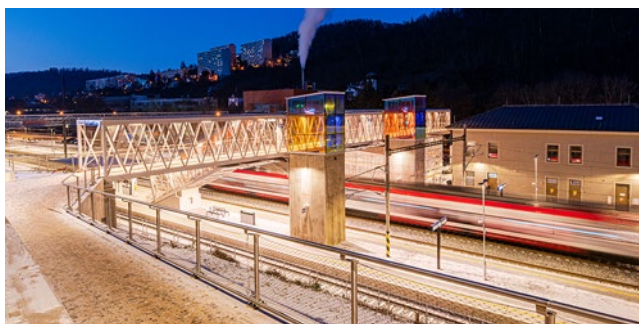
Modernizace železniční stanice Adamov a nová lávka Eva Ing. Jan Parchanský (ČKAIT 0010872, ID00)
