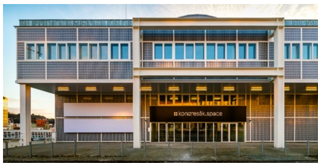
Brno – Rekonstrukce a přestavba Kongresového centra Ing. Jan Helešic (ČKAIT 1004728, IP00)
