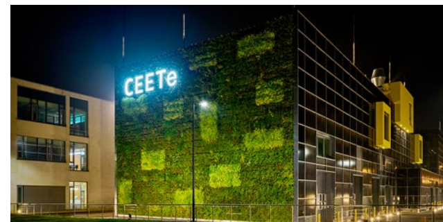
Ostrava Poruba – Centrum energetických a environmentálních technologií – explorer (CEETe) Ing. Martin Ciešlar (ČKAIT 1103987, IP00)
