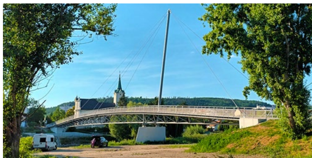
Ocelová lávka přes Berounku v Radotíně Ing. Vladimír Janata (ČKAIT 0001044, IM00, IS00)
