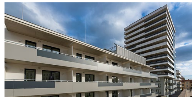
Brno – Polyfunkční dům Ponávka Tower v Zábřevě Martin Čaňo (ČKAIT 1003292, SP00)
