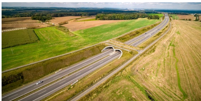
Dálnice D3 – 0309-II, úsek Ševětín – Borek
