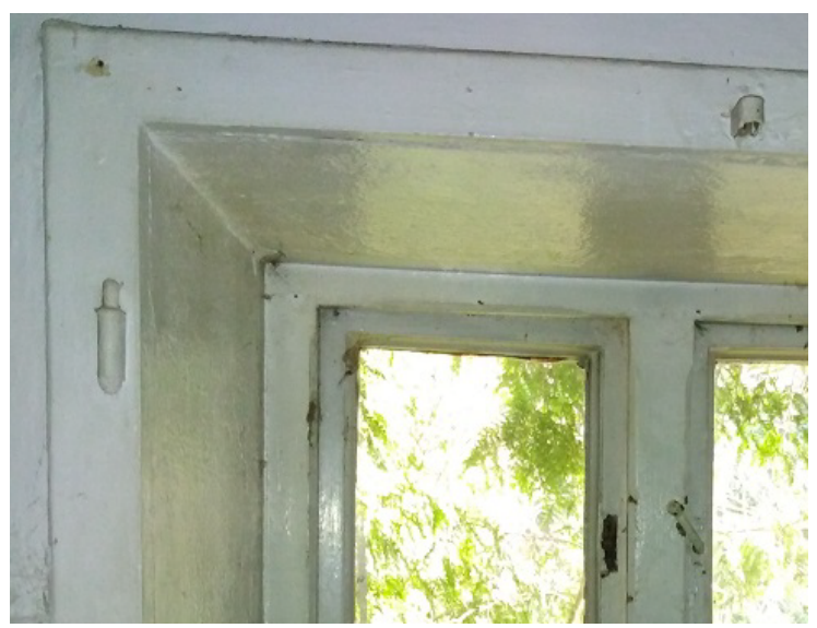
nepůvodní vnitřní křídlo chybí
