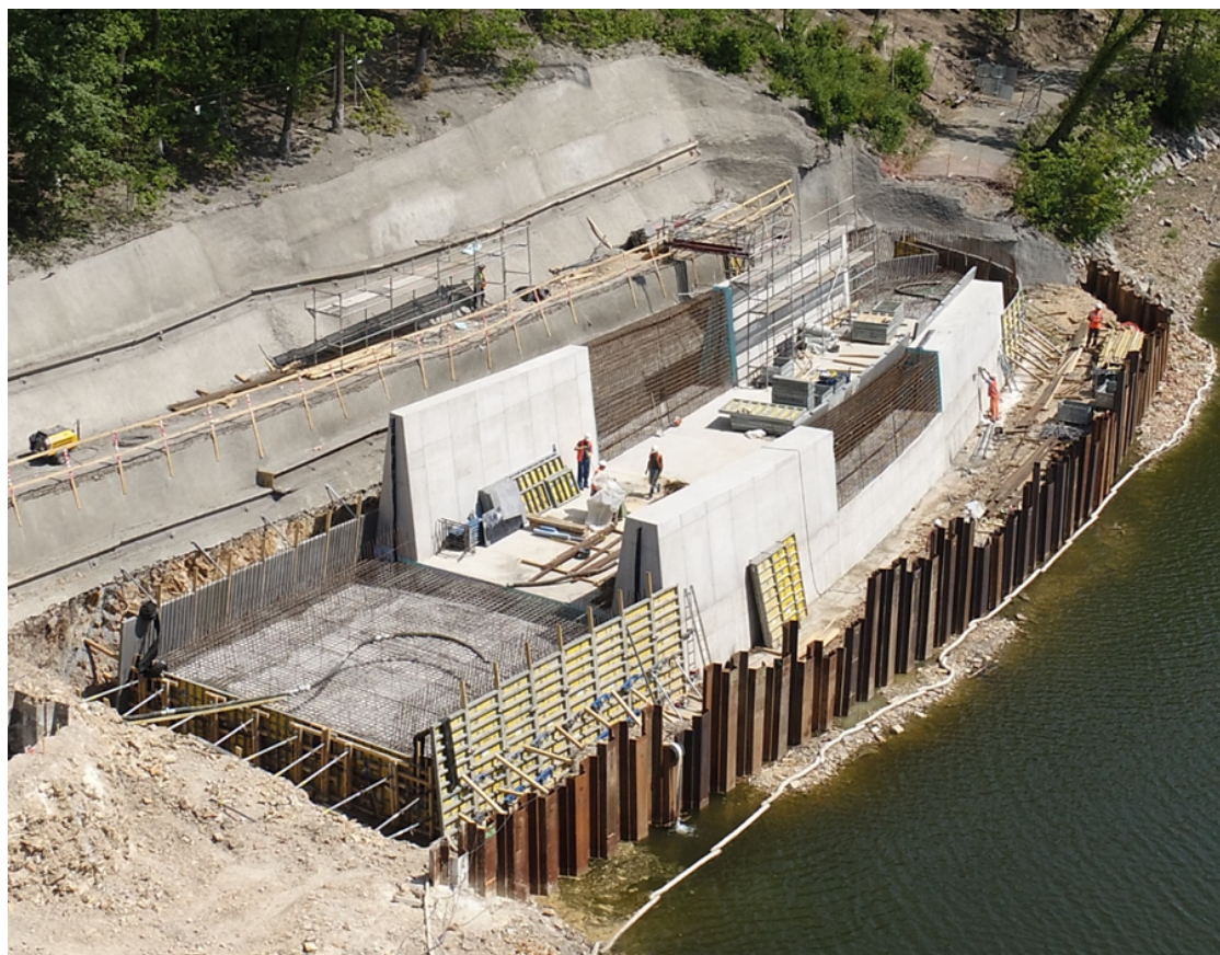
Obr. 6 Realizace železobetonových konstrukcí přelivu
