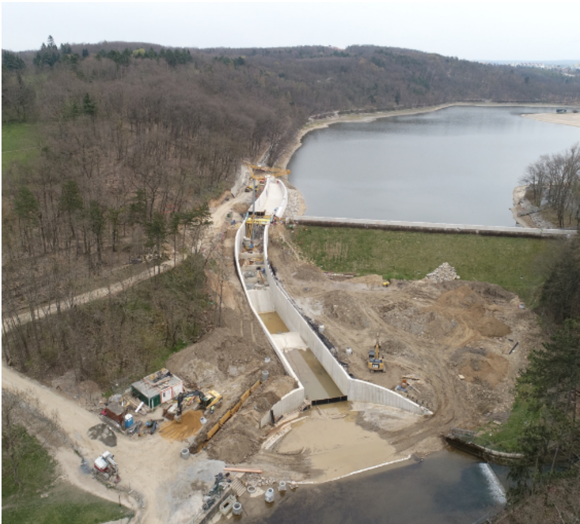
Obr. 7 Nová konstrukce bezpečnostního přelivu VD Hostivař
