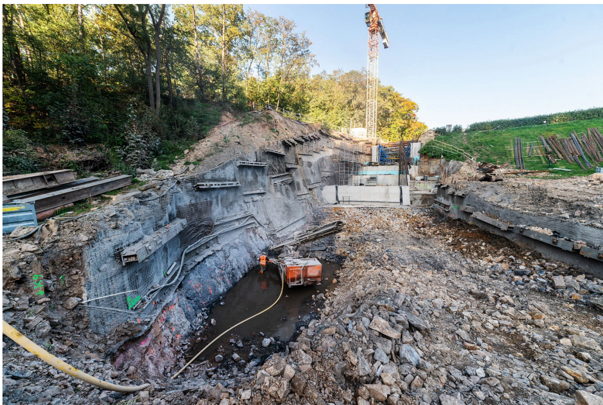
Obr.5 Zajištění stavební jámy v podhrází
