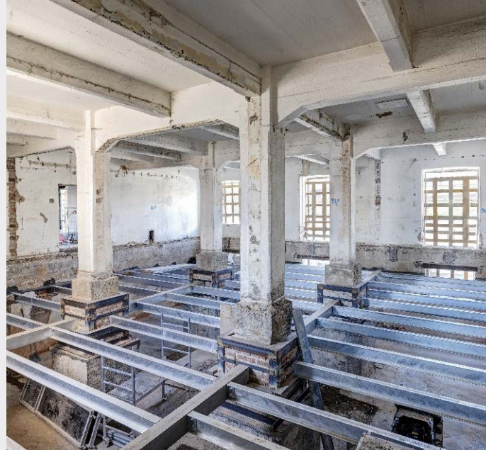
▲ Obr. 15 Nový strop nad sklepem
