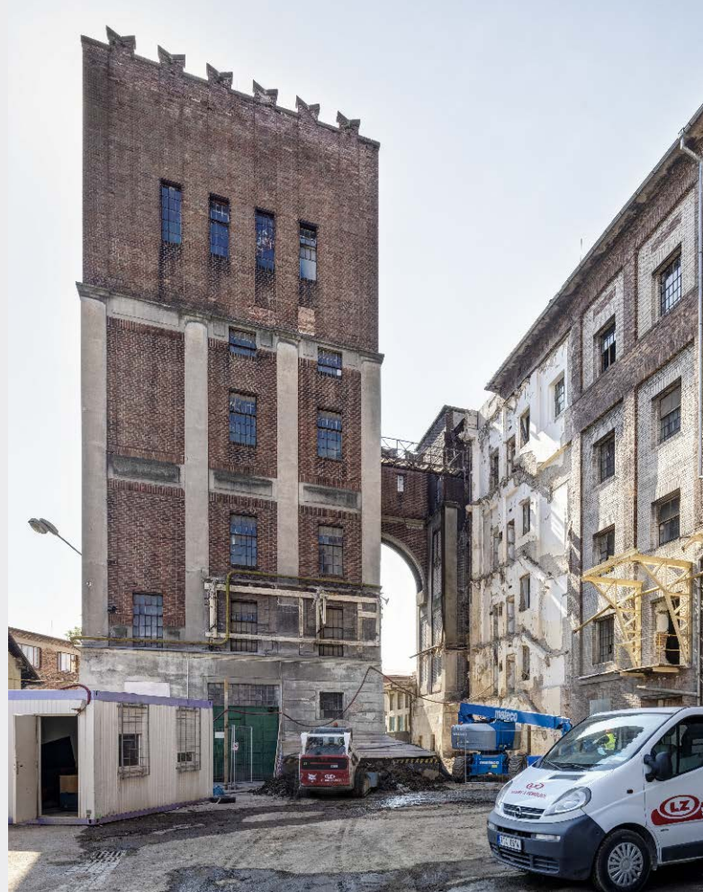
▲ Obr. 3 Východní fasáda hlavní budovy po demolici nepůvodního schodiště
