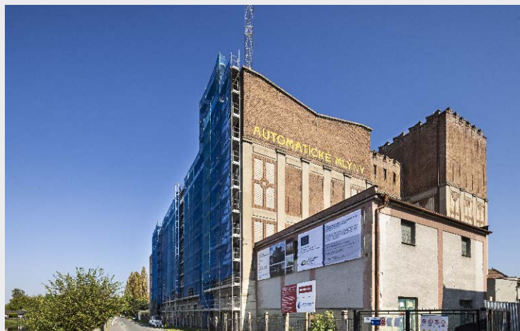
▼ Obr. 4 Obnova západní fasády hlavní budovy
