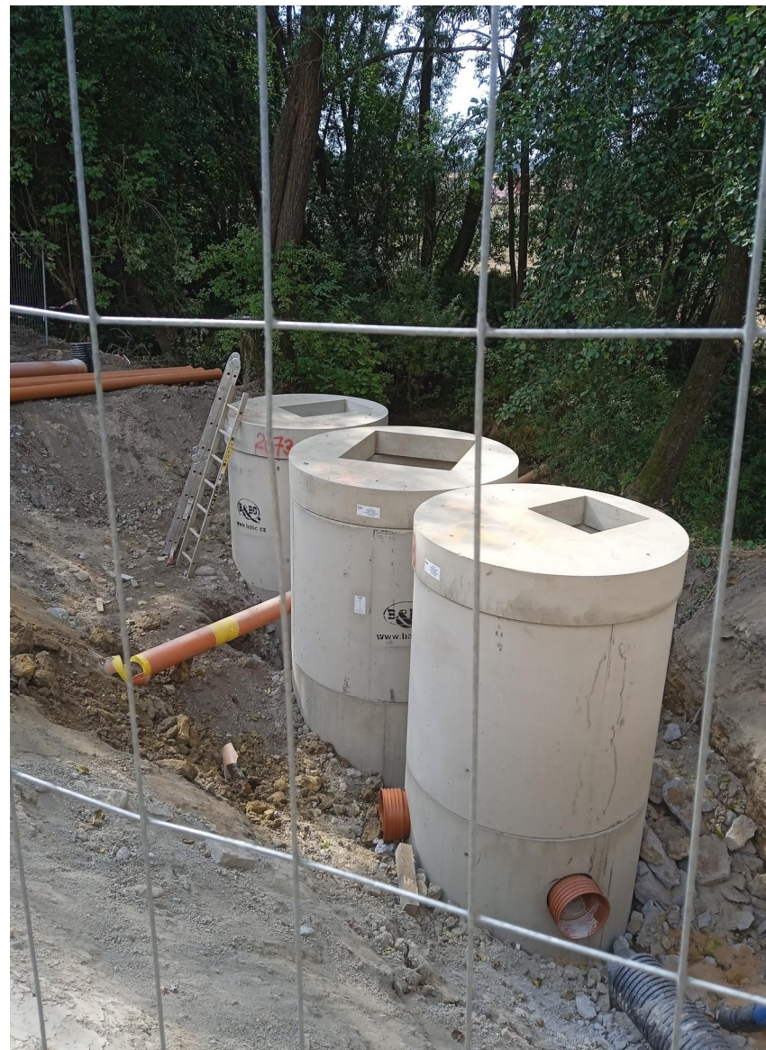
Obrázky 4 a 5: Shybková sestava vyrobená z typového skružového výrobního programu betonárky BaBC, napojování na potrubí.
