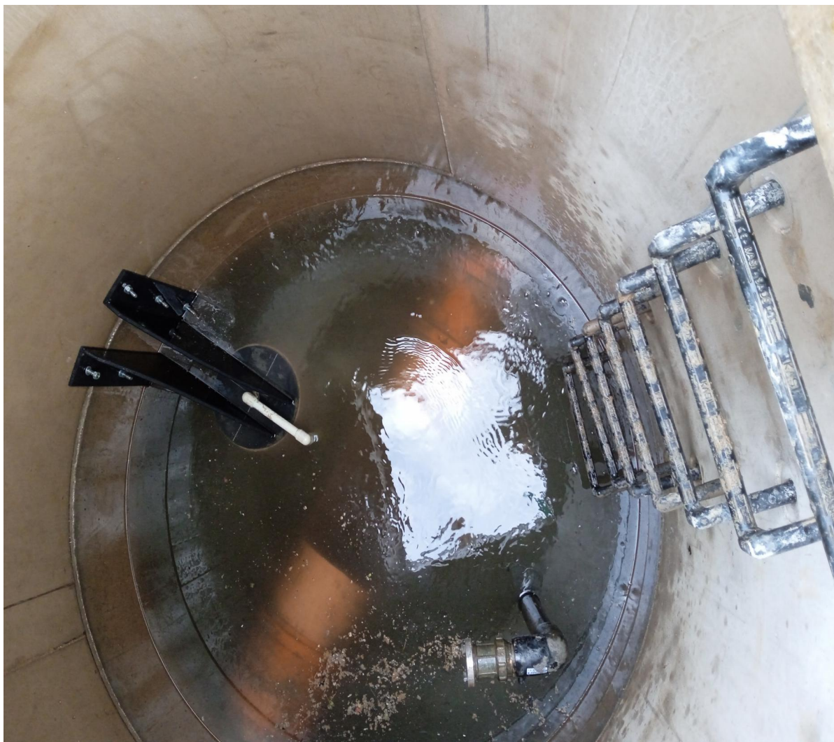
Obrázky 10 a 11: Shybka „WDG – Semerád“ v akci, po naplnění retenčního prostoru je tento cyklicky vyprazdňován s vysokou rychlostí, to je dokumentováno na pravé fotografii (DK). Vše funguje podle předpokladu. HKS je vybavena zvonem na sifonovém potrubí, princip viz přílohy 2 a 4.
