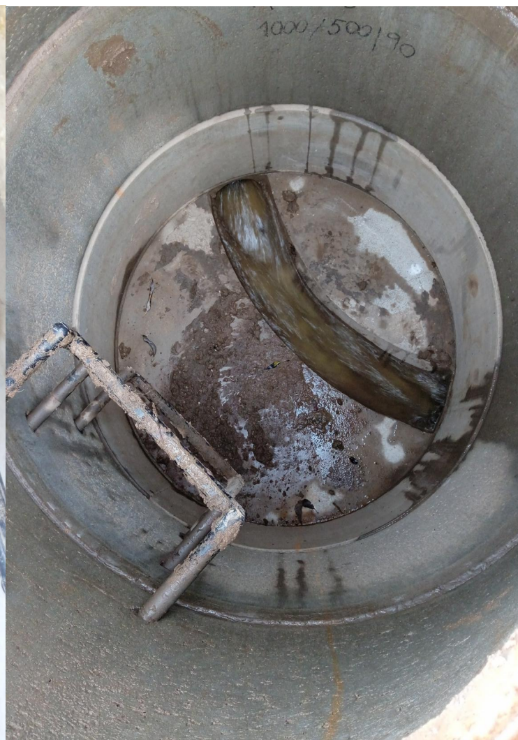
Obrázky 10 a 11: Shybka „WDG – Semerád“ v akci, po naplnění retenčního prostoru je tento cyklicky vyprazdňován s vysokou rychlostí, to je dokumentováno na pravé fotografii (DK). Vše funguje podle předpokladu. HKS je vybavena zvonem na sifonovém potrubí, princip viz přílohy 2 a 4.
