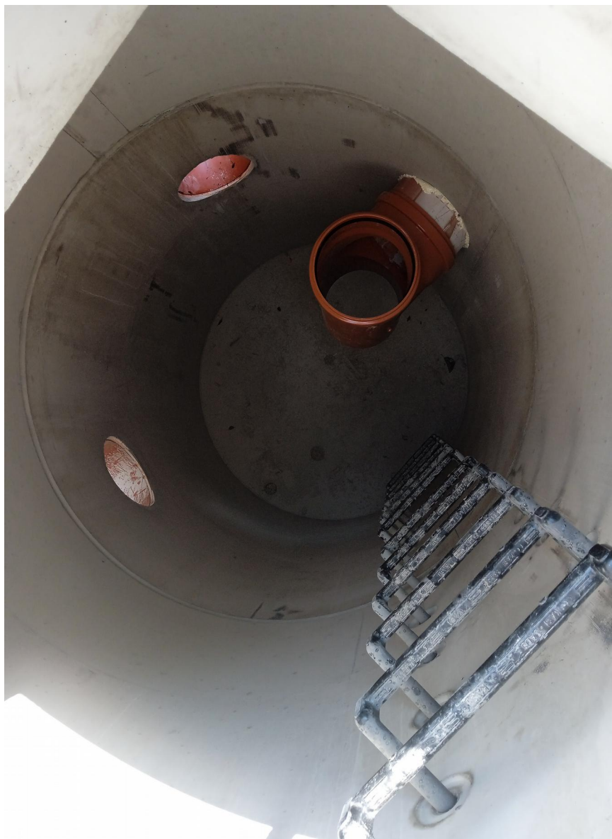
Obrázky 6 a 7: Levá komora – spojovací šachta s lapačem písku a čistícím T-kusem, pravá sifonové potrubí před dobetonováním dna.
