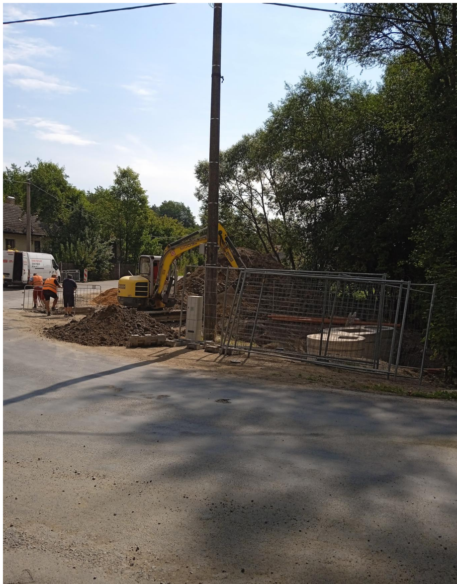
Obrázky 4 a 5: Shybková sestava vyrobená z typového skružového výrobního programu betonárky BaBC, napojování na potrubí.
