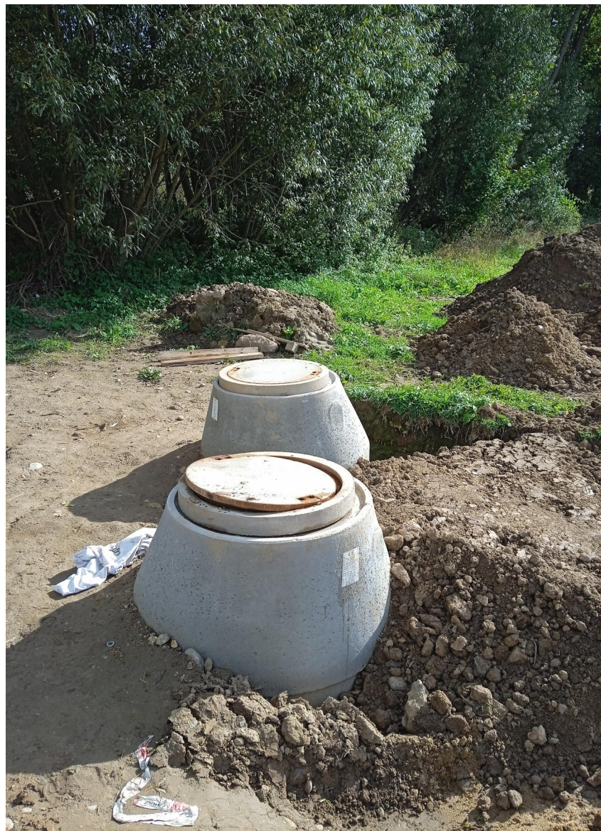
Obrázky 8 a 9: HKS = horní komora shybky s hrubým předčištěním (levá), DKS = dolní komora shybky (pravá).
