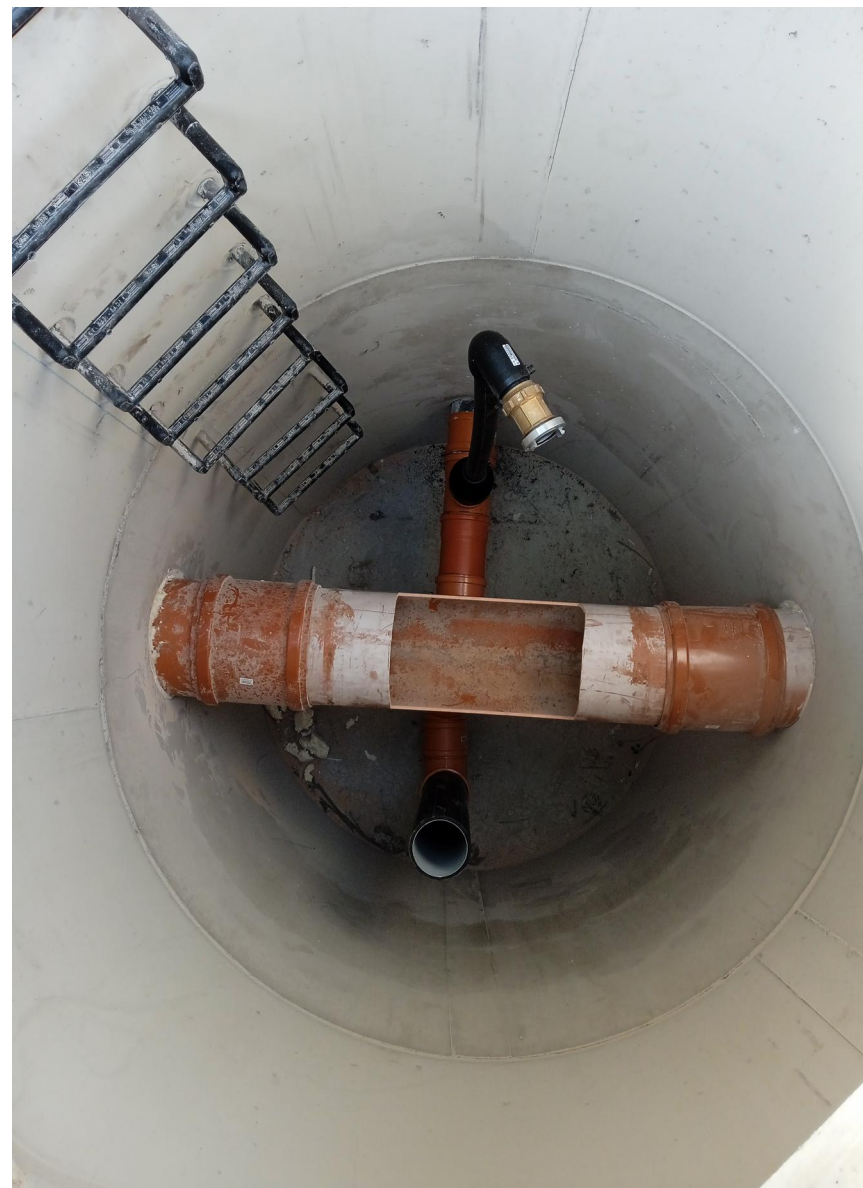
Obrázky 6 a 7: Levá komora – spojovací šachta s lapačem písku a čistícím T-kusem, pravá sifonové potrubí před dobetonováním dna.
