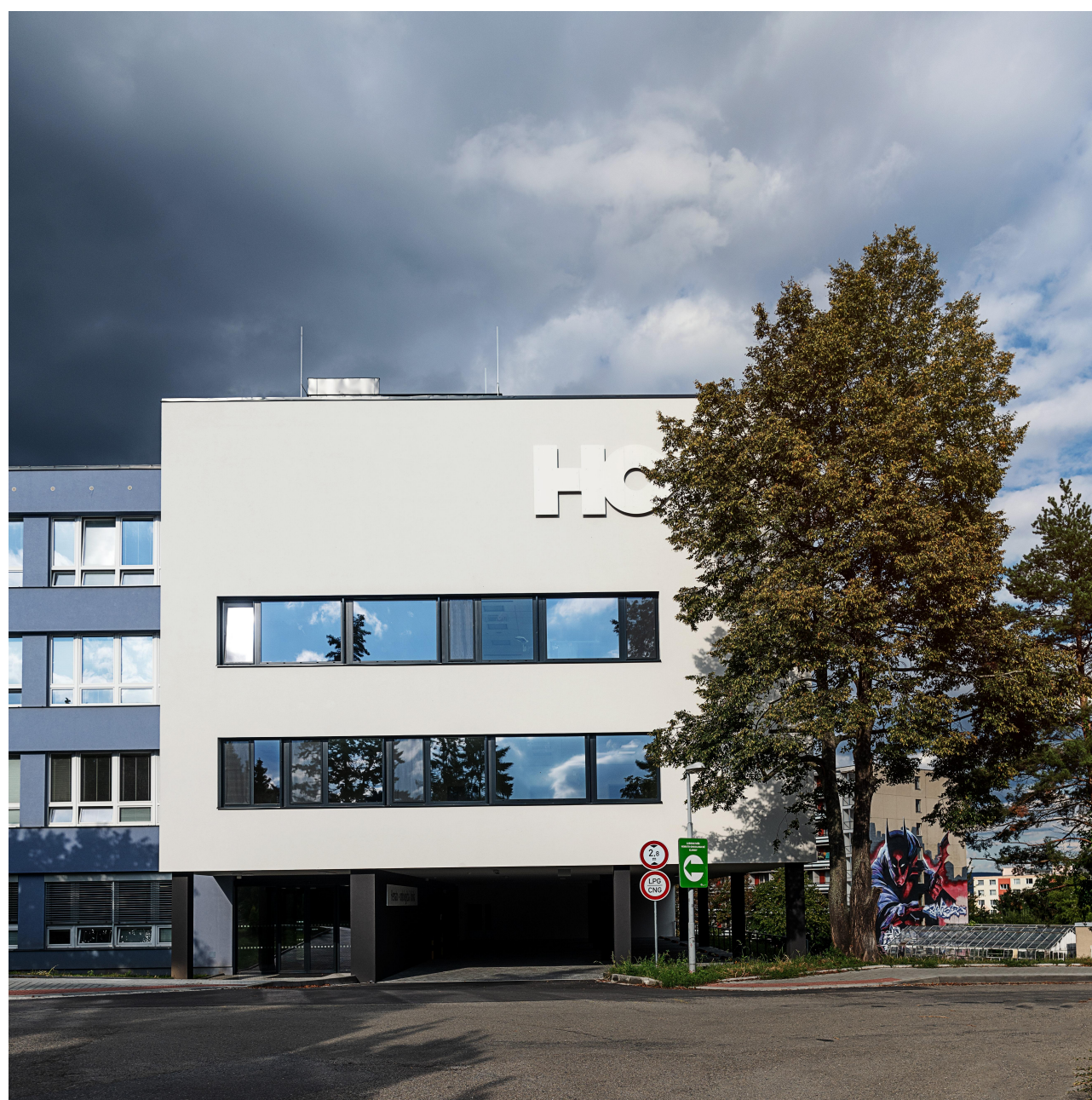
HOK I západní pohled na budovu
